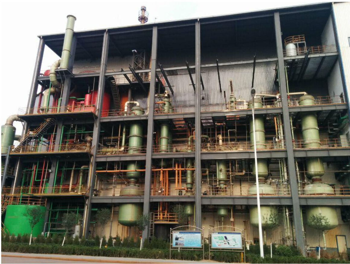
图 6.1-1 现有工程氯化尾气处理装置
